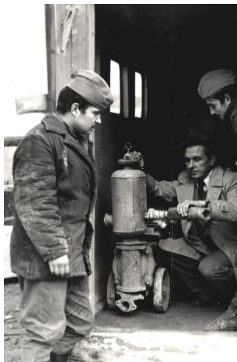
Рева С.Н. на ш. Павлоградская. Подготовка растворонасоса для тампонажа. 1968 г.
