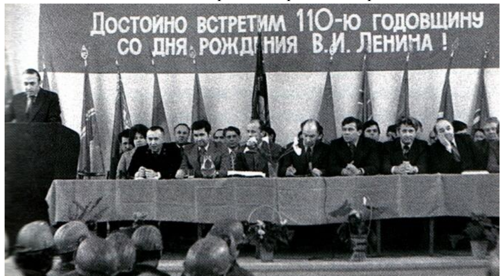
Собрание по случаю сдачи шахты 16/17 в эксплуатации. На трибуне – начальник комбината «Днепрошахтострой» Непон Н.Р. – выпускник кафедры СШ и ПС
