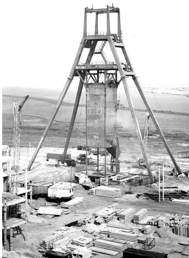
Сооружение копра на шахте им. Героев космоса
