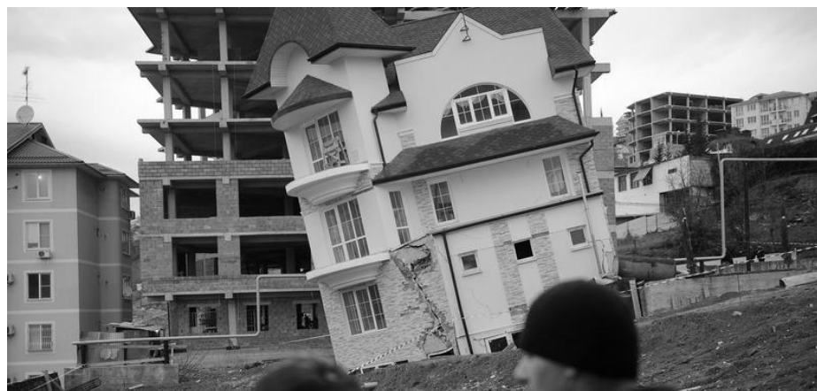
Рисунок 3 – Последствия обрушения 3.03.2013 г. в тоннеле №8а
