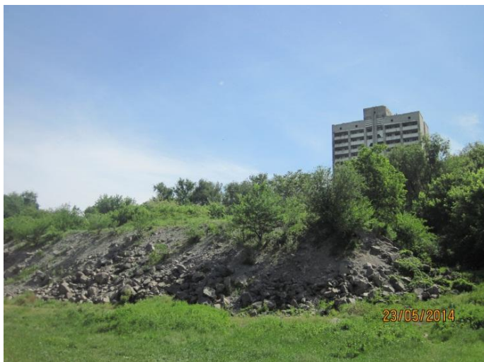
Рисунок 1 – Рыбальская балка, отселенные дома вследствие подвижек склона; укрепительный контрбанкет, май, 2014 год
