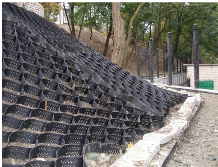
Рисунок 4– Пример применения георешетки для закрепления склона
