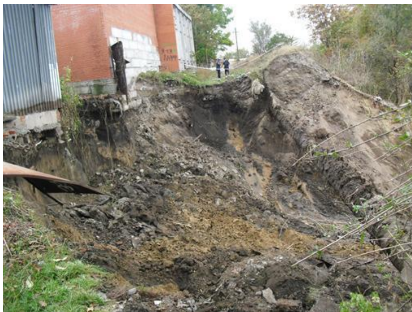
Рисунок 3 – Оползень в г. Днепропетровск. Рыбальская балка, ул. Войцеховича, 2 ноября 2011 года
