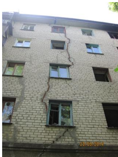
Рисунок 1 – Рыбальская балка, отселенные дома вследствие подвижек склона; укрепительный контрбанкет, май, 2014 год
