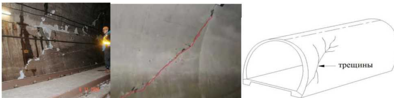
Рис. 3. Форма повреждения – наклонные трещины
