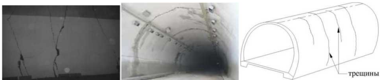
Рис. 2. Форма повреждений – поперечные трещины
