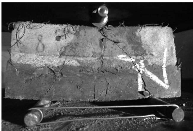
Рис. 4. Основа и восстановленное покрытие – фибробетон с жесткой фиброй
