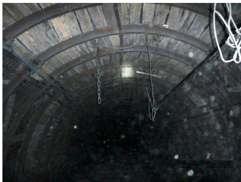
Рис. 7.4. Фрагмент состояния 594 сборного штрека на экспериментальном участке
