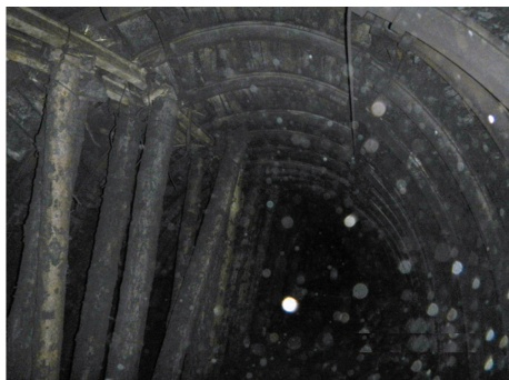
Рис. 2.6. Состояние 590 сборного штрека на расстоянии не менее 30 м (ПК11) позади 590 лавы
