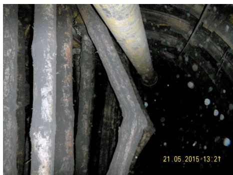
Рис. 5.4. Общий вид крепежной системы выемочной выработки позади лавы: а – выполаживание и пластические деформации верхняков рамы; б – разрушения центральных (деревянных) стоек крепи усиления
