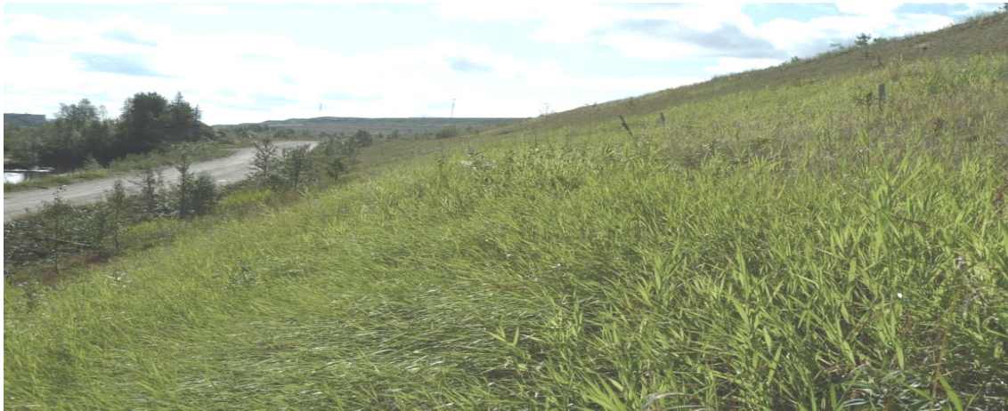
Рис. 2. Вид откоса дамбы хвостохранилища с использованием жидких полимерных растворов
