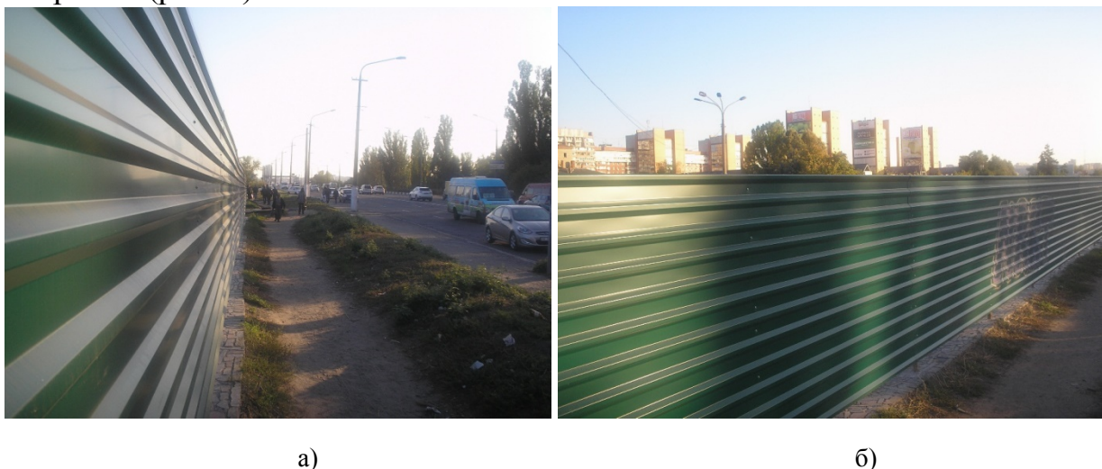
Рис.6. Типовая схема размещения экрана высотой 2,5 м: а) – вид со стороны автострады на мосту; б) – вид со стороны жилого массива, соответственно
