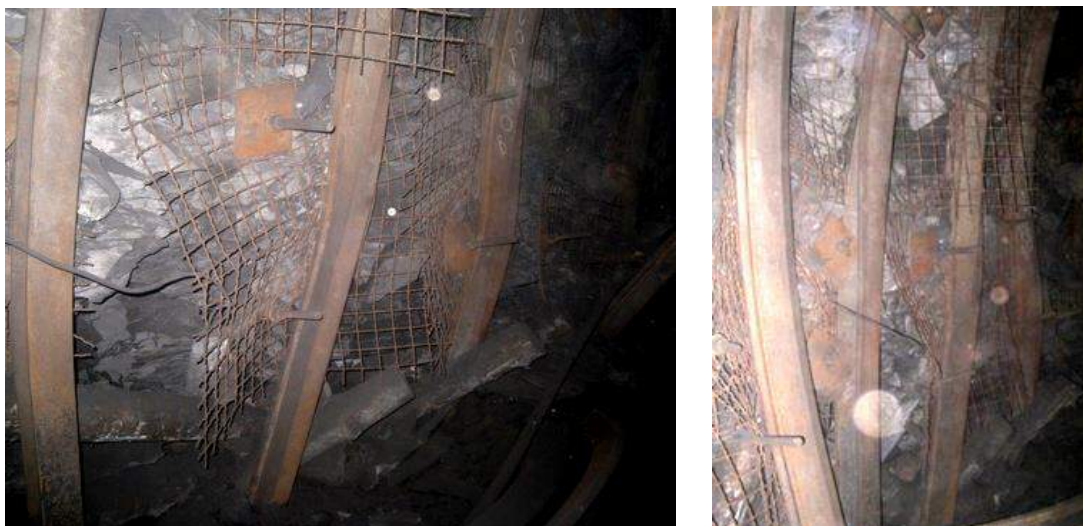
Рис. 5.23. Деформація стійок аркового кріплення
