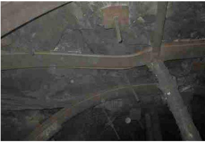
Рис. 5.17. Скручування елементів кріплення і витискання порід у виробку
