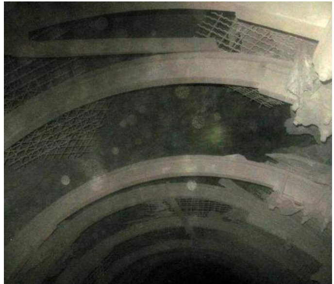
Рис. 3.21. Відсутність верхніх міжрамних стяжок
