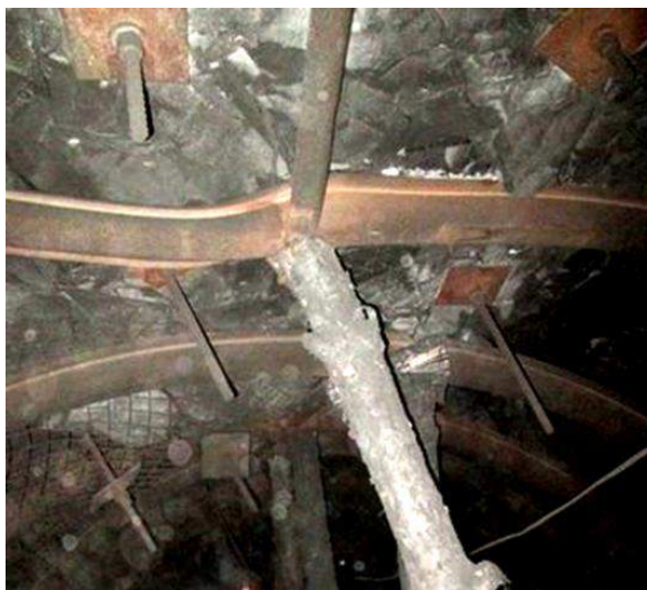
Рис. 5.21. Установлення анкерного кріплення з порушенням технології
