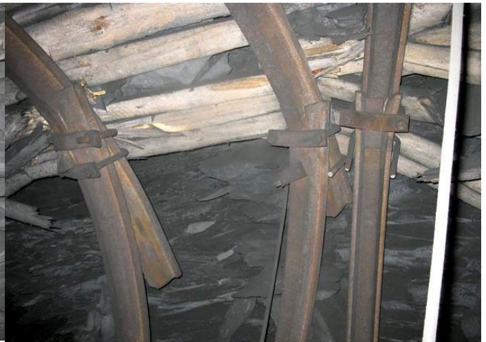
Рис. 3.17. Місця руйнування рамного кріплення
