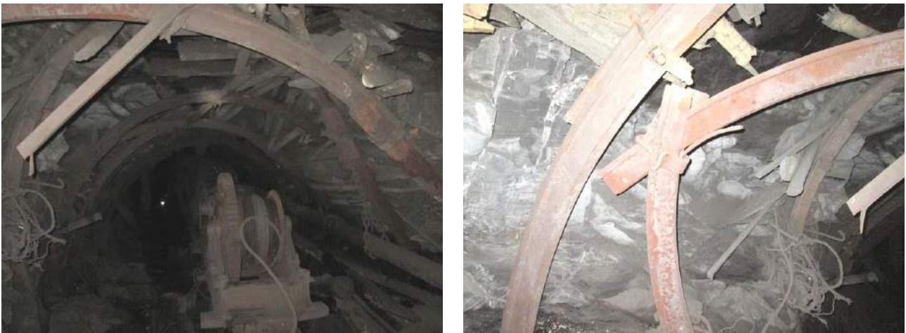
Рис. 3.10. Аварійна ділянка виробки
