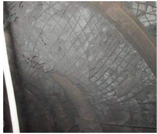
Рис. 5.17. Скручування елементів кріплення і витискання порід у виробку
