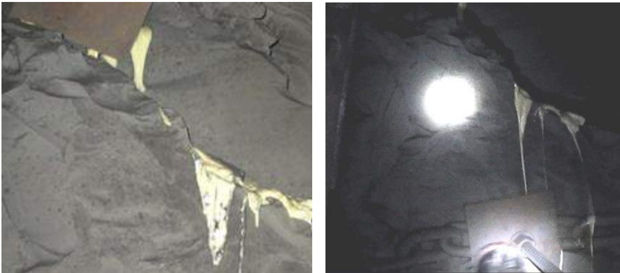
Рис. 5.49. Витікання складу через тріщини в масиві
