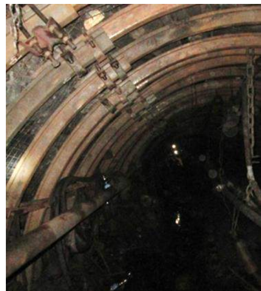
Рис. 5.20. Перекріплена ділянка
