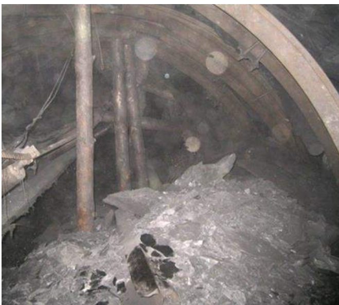
Рис. 5.19. Стан виробки до перекріплення
