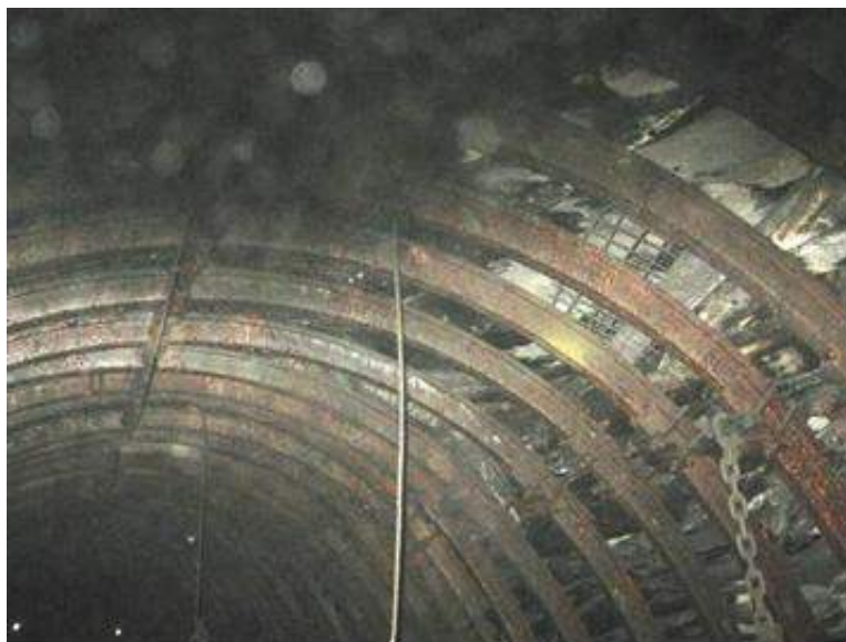
Рис. 3.15. Стан кріплення в районі сполучення з конвеєрним уклоном
