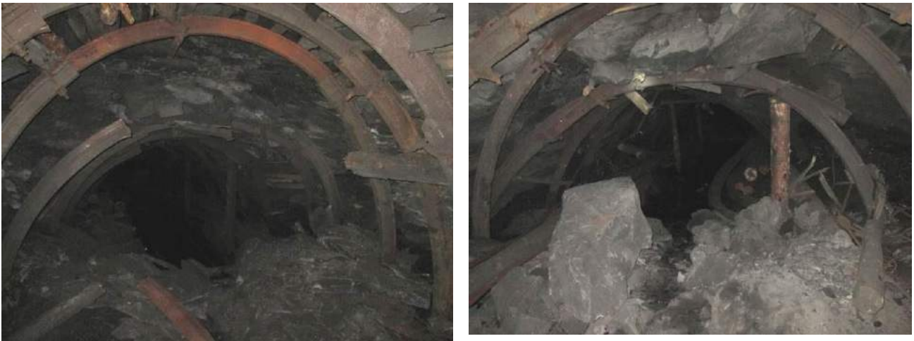
Рис. 3.9. Вивали порід покрівлі та боків виробки
