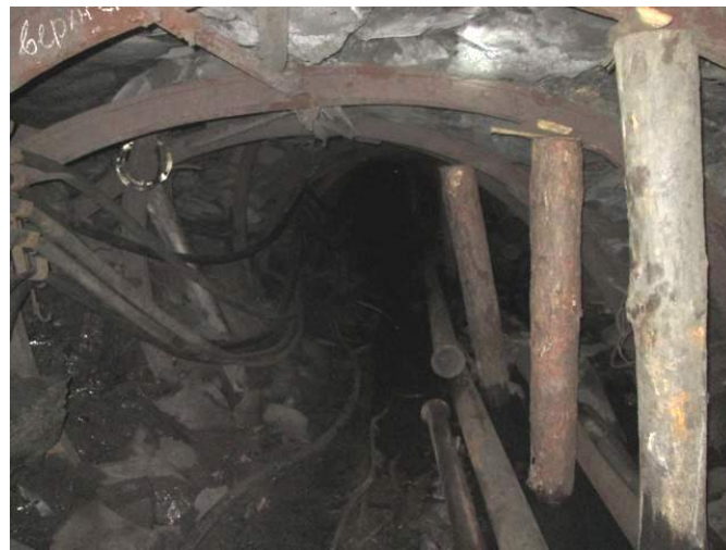
Рис. 3.12. Встановлення дерев'яних стійок підсилення під нижню ніжку кріплення і руйнування верхньої ніжки
