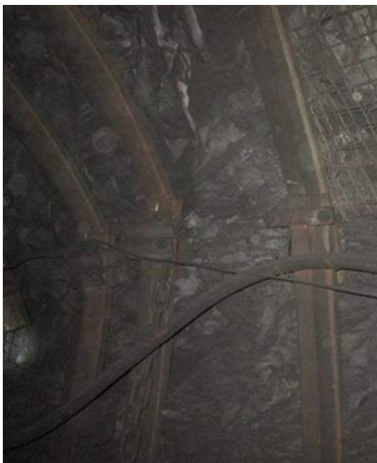
Рис. 5.24. Місця руйнування замкових з'єднань
