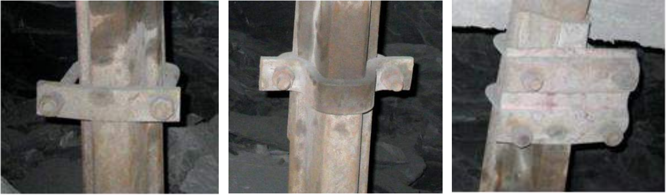
Рис. 3.19. Використання хомутів і планок різних типів
