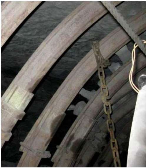
Рис. 3.19. Використання хомутів і планок різних типів
