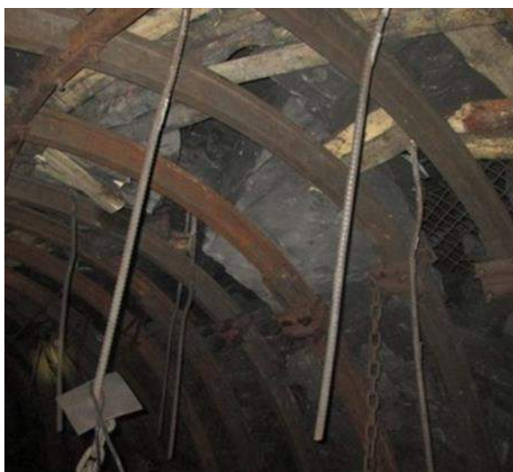
Рис. 5.22. Анкерне кріплення після випуску породи з покрівлі
