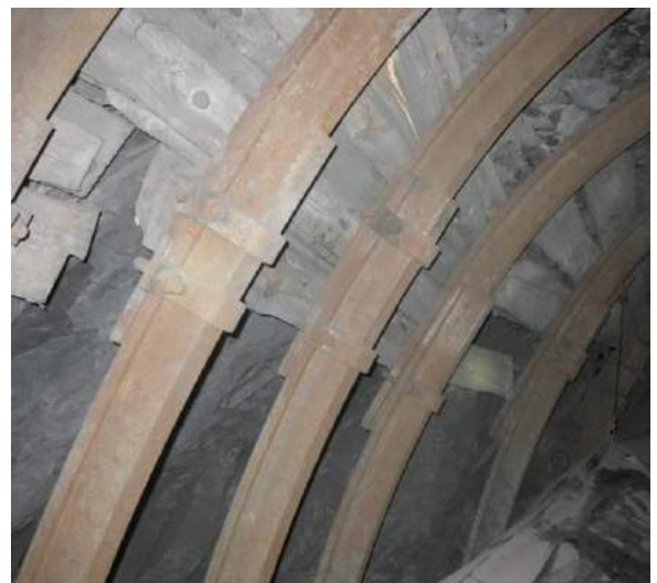
Рис. 3.23. Відсутність затяжки в боках виробки
