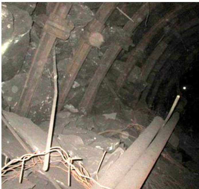
Рис. 5.25. Вивали порід з боку виймального вибою
