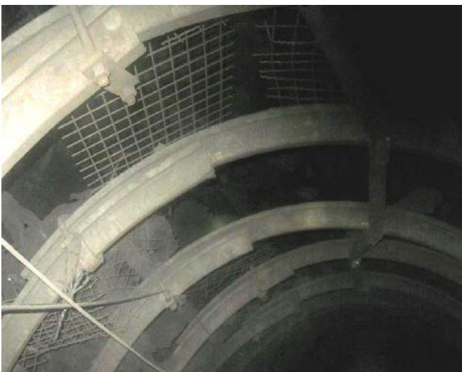
Рис. 3.22. Відсутність затяжки в покрівлі виробки
