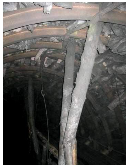
Рис. 3.18. Відсутність затяжки (а) і стійок (б)
