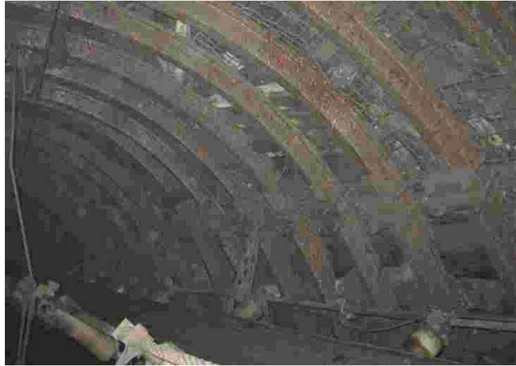
Рис. 5.14. Стан кріплення пром. штреку після відкачки води
