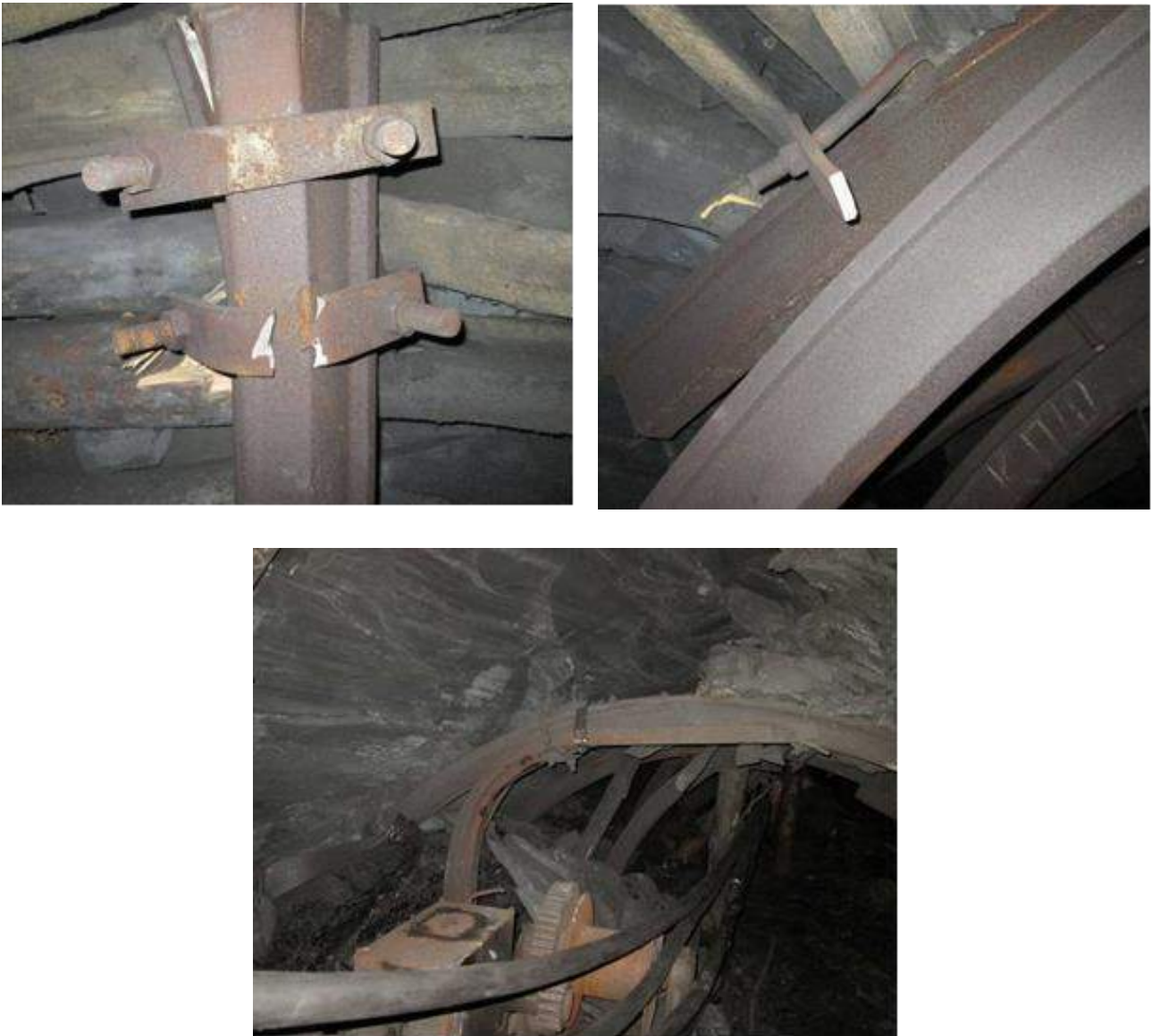
Рис. 3.14. Руйнування і деформування елементів металевого кріплення, відсутність затяжка
