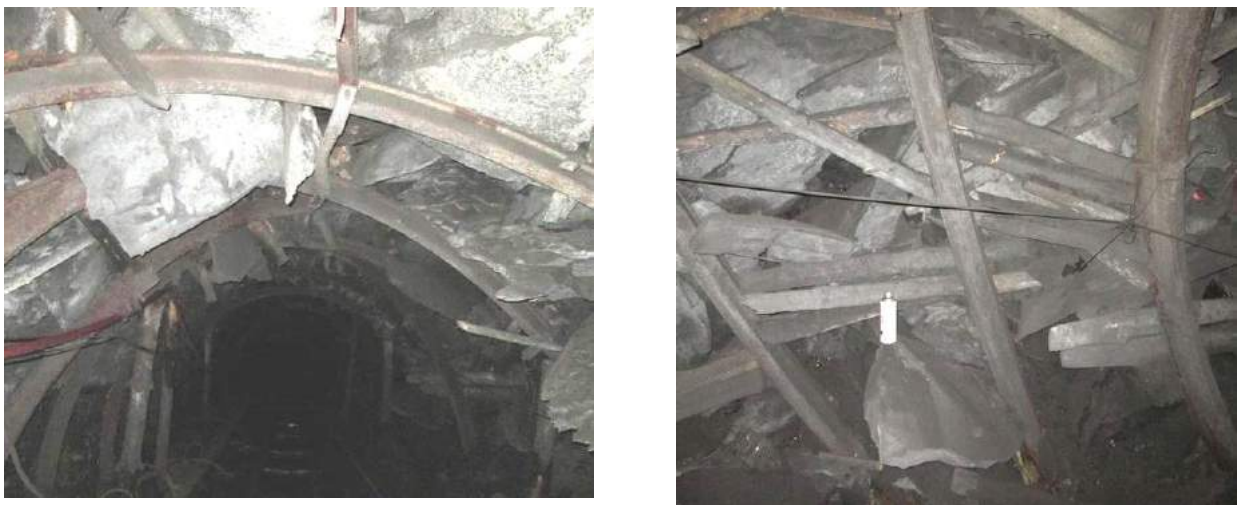
Рис. 3.8. Навіси порід і завал рам кріплення
