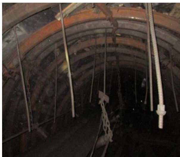
Рис. 5.22. Анкерне кріплення після випуску породи з покрівлі
