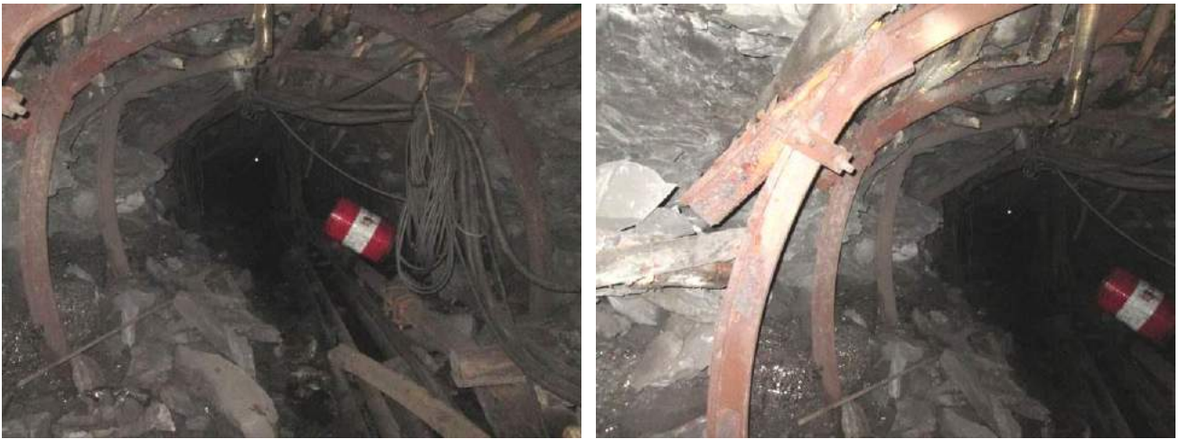
Рис. 3.11. Ділянка виробки з деформованим кріпленням
