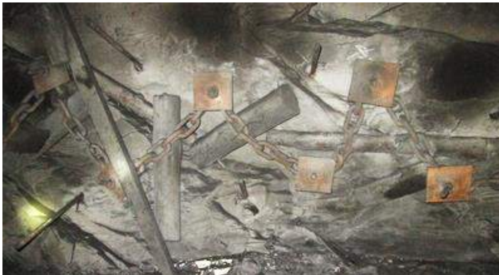
Рис. 5.48. Встановлення анкерного кріплення
