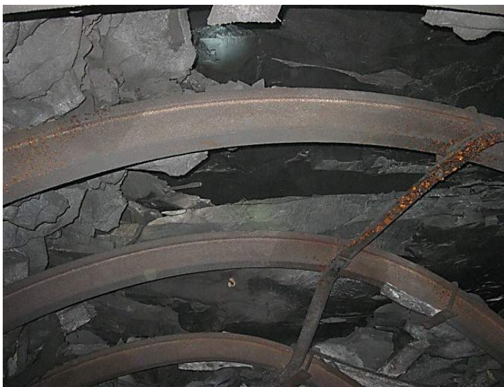
Рис. 3.18. Відсутність затяжки (а) і стійок (б)
