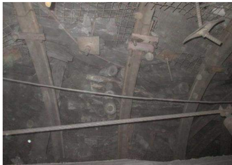
Рис. 5.18. Відсутність органного кріплення
