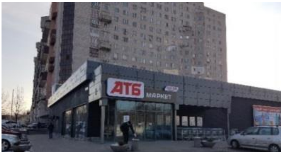
Рис. 2.2. Вентиляльований фасад магазину «АТБ»
