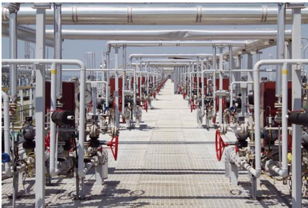
Рис. 7.4. Зливно-наливна залізнична естакада
