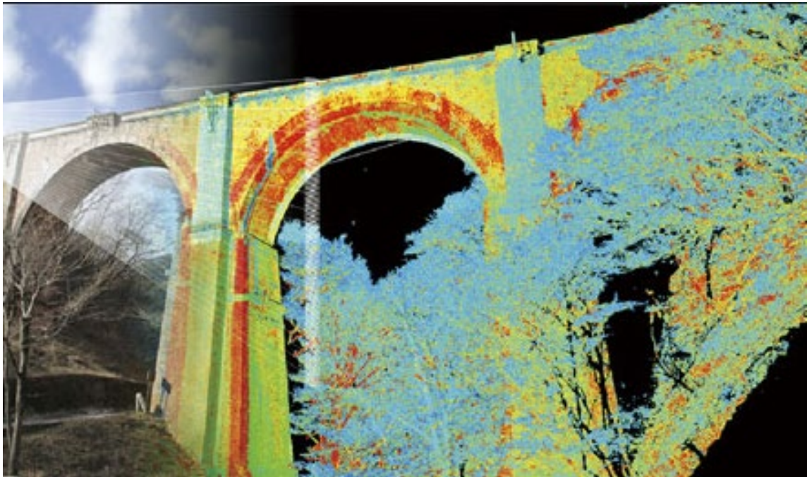
Рисунок 3.3 – Хмара точок, отримана за допомогою лазерного сканера
