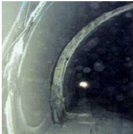
Рис. 1. Разрушение тоннеля при сдвиге грунта в зоне разлома
