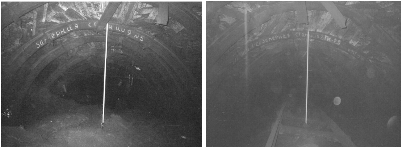
Рис. 4.14. Обладнані замірні станції № 2 і № 3 і фактичний стан 7-го південного бортового хідника південної панелі №1
