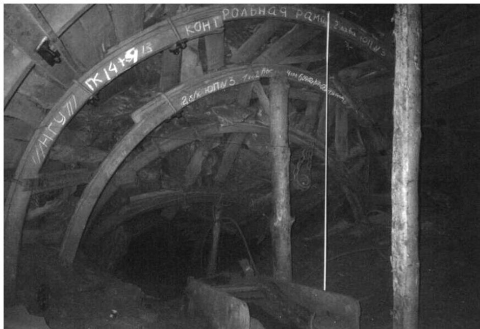
Рис. 4.18. Стан 2-го бортового хідника ПП №3
