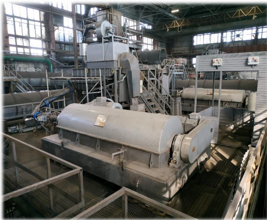
Рис. 1. Внешний вид барабанного сита Ecomash 1308 и осадительной центрифуги Ecomash SHS 751A-113 на площадке ЦОФ «Павлоградская»
