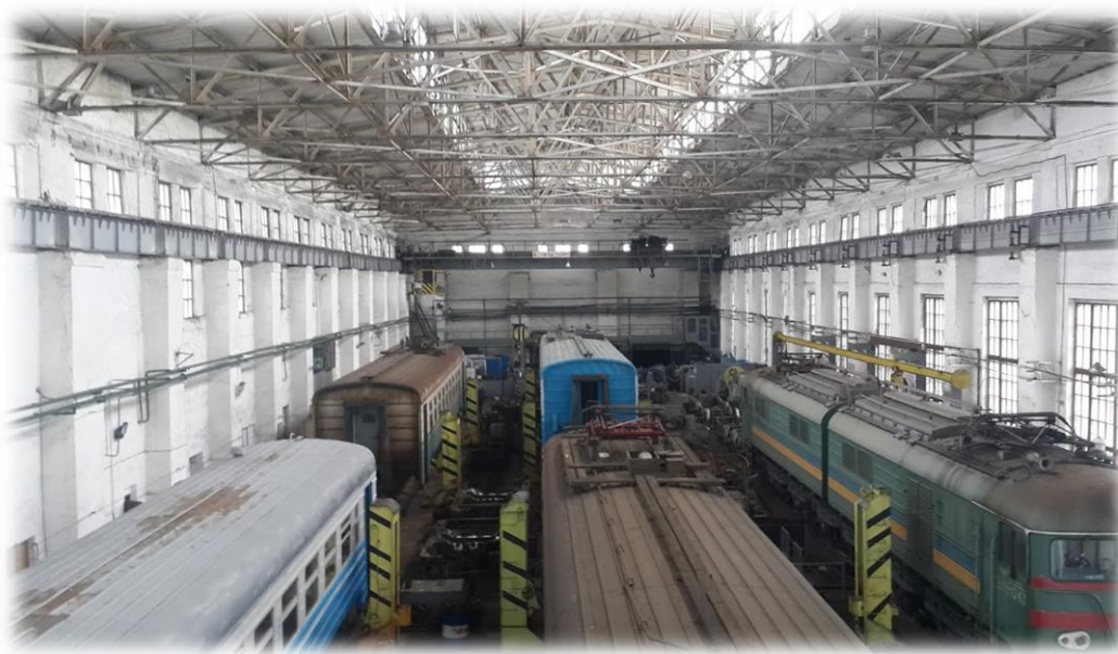
Рисунок 1.4 – Вид основної будівлі депо з середини
