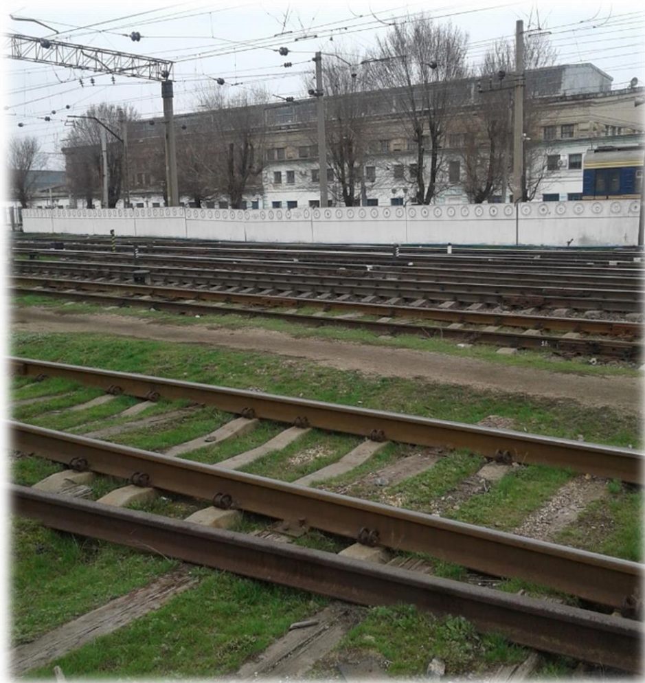
Рисунок 1.2 – Загальний вид будівлі
