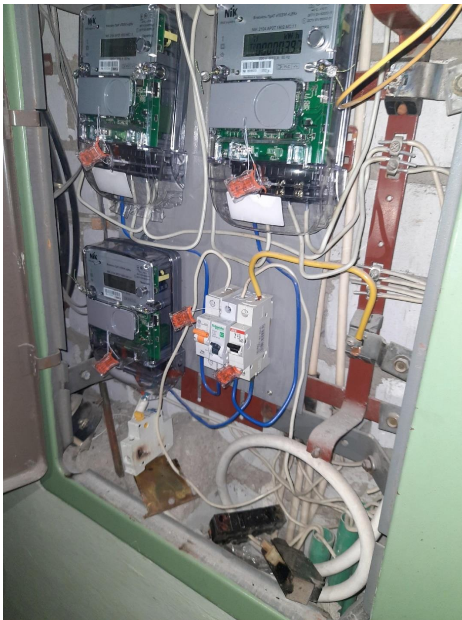
Рисунок 2.1 Опломбування автоматів обмеження потужності без захисного корпусу
