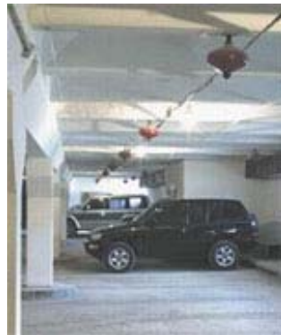
Рисунок 1.10 – Автоматична установка пожежогасінні на основі модулів порошкової пожежогасінні «Ураган-1»
