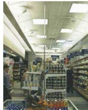
Рисунок 1.10 – Автоматична установка пожежогасінні на основі модулів порошкової пожежогасінні «Ураган-1»
