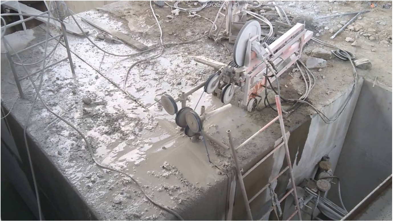
Рис. 2.9 – Загальний вигляд канатної пилки в роботі при відділенні блоку
