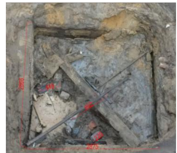
Рис. 6.1 – Фото виявленого шахтного вертикального безномерного шурфу
