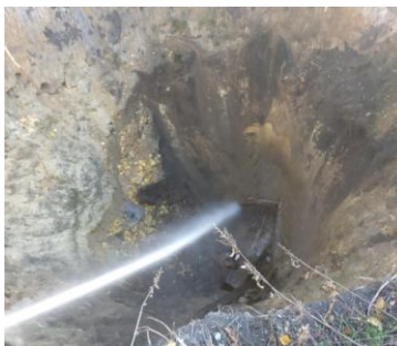
Рис. 6.1 – Фото виявленого шахтного вертикального безномерного шурфу
