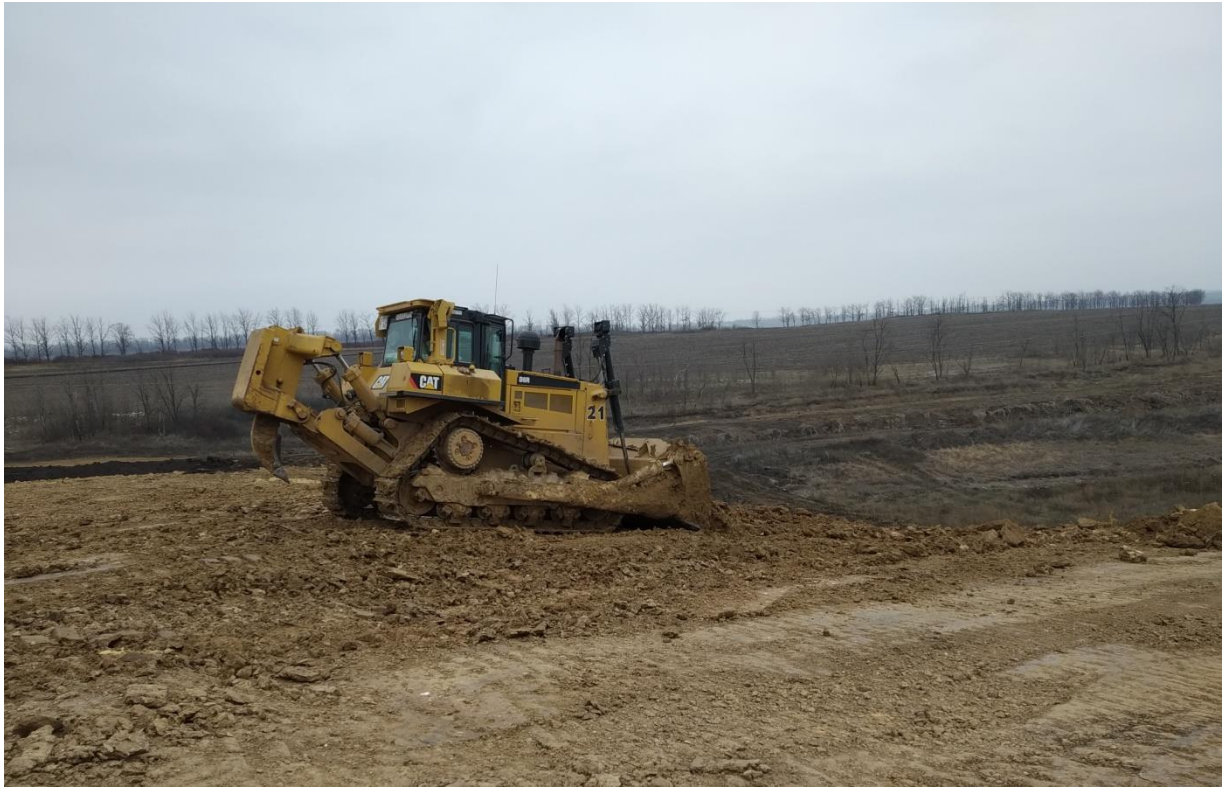
Рис. 2.1. Загальний вигляд роботи бульдозера Cat D8R при формуванні відвалу
