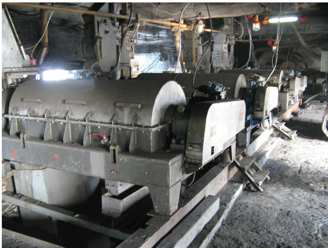
Рис. 7.25. Общий вид размещения центрифуг ОГШ на «Моспинском» УПП
