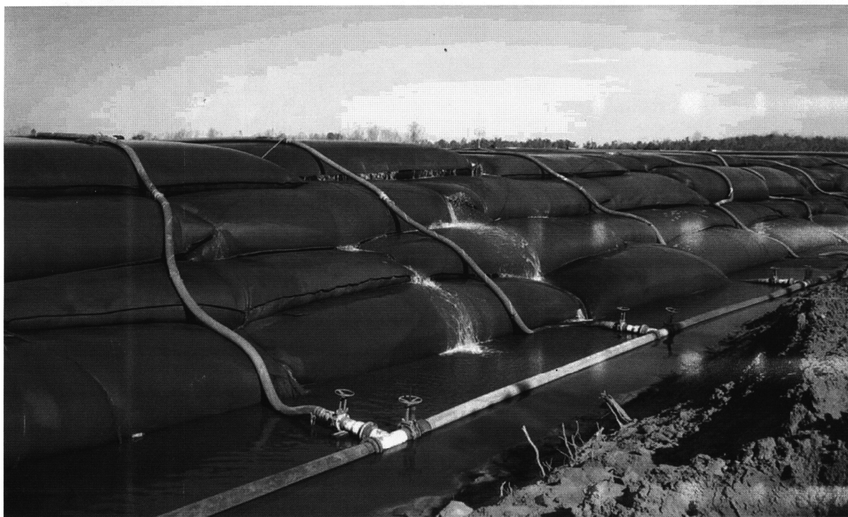
Рис. 7.19. Вид наполненных контейнеров
