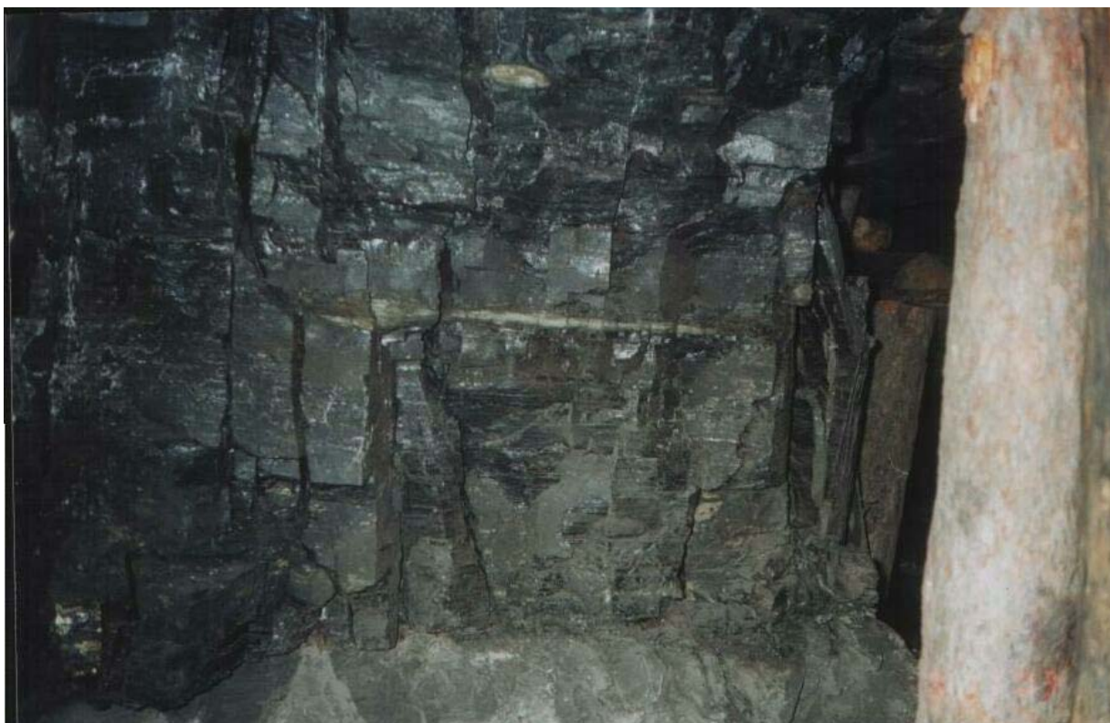
Рис. 2.4. Трещины отжима угольного пласта, зафиксированные в центре лавы при проведении «присечки» 407-й лавы ш. «Благодатная»
