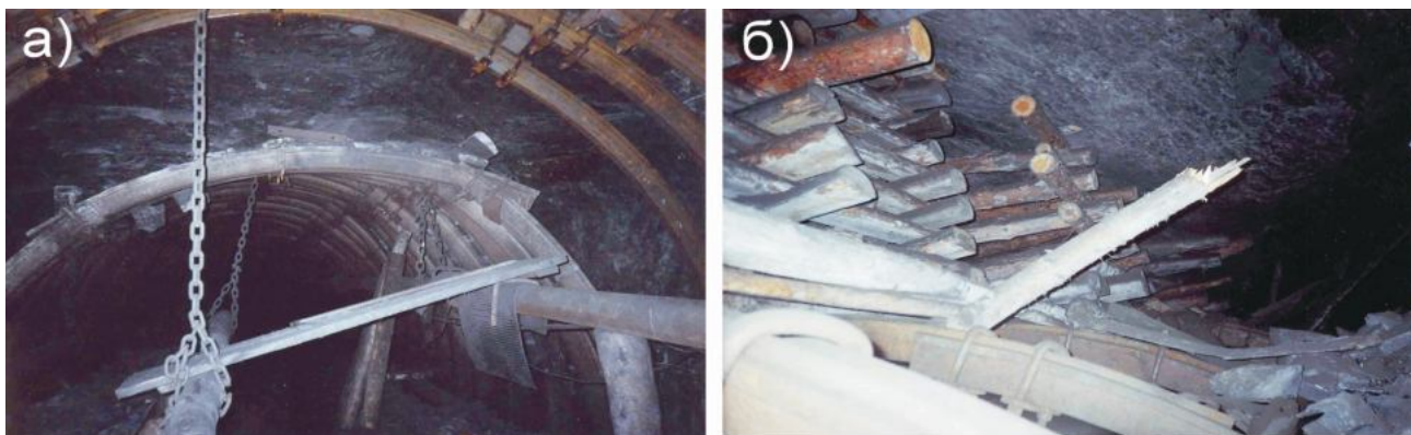
Рис. 1. Фрагменты аварийных участков выработок а) деформация крепи и выход из строя узлов податливости; б) куполообразование в результате вывала пород
