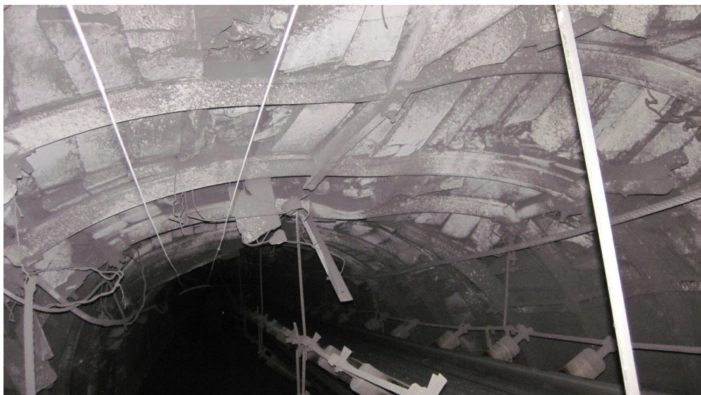
Рис. 2. Пример негативного проявления горного давления в протяженных выработках южного крыла шахты «Россия»
