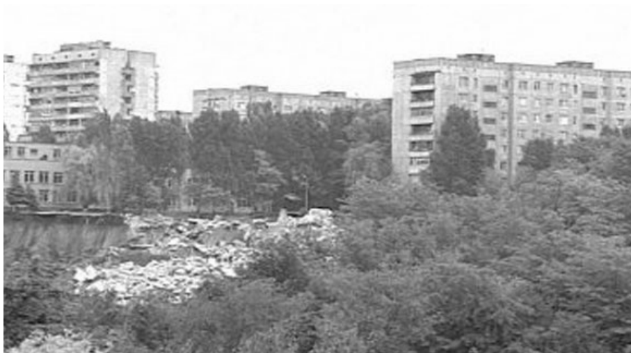
Рис. 1. Участок жилого массива "Тополь" (Днепропетровск) после оползня в июне 1997 г.
