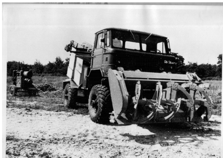
Рисунок 4.1 – Установка для вилучення металів з ТПВ на базі снігонавантажувача
