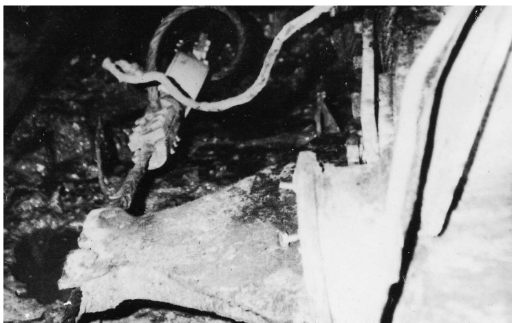
Рис.1.15. Включение динамометра в контур тягового каната
