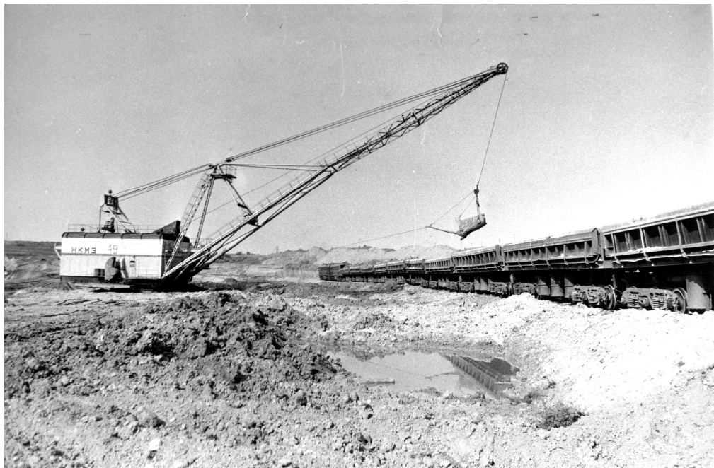
Рисунок 3.8 – Схема навантажування гірничої маси драглайном ЕШ-10/70 до думпкарів 2ВС105
