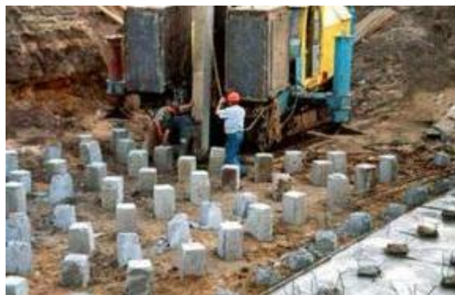
Рис. 2. Общий вид свайного поля при строительстве гостиничного комплекса
