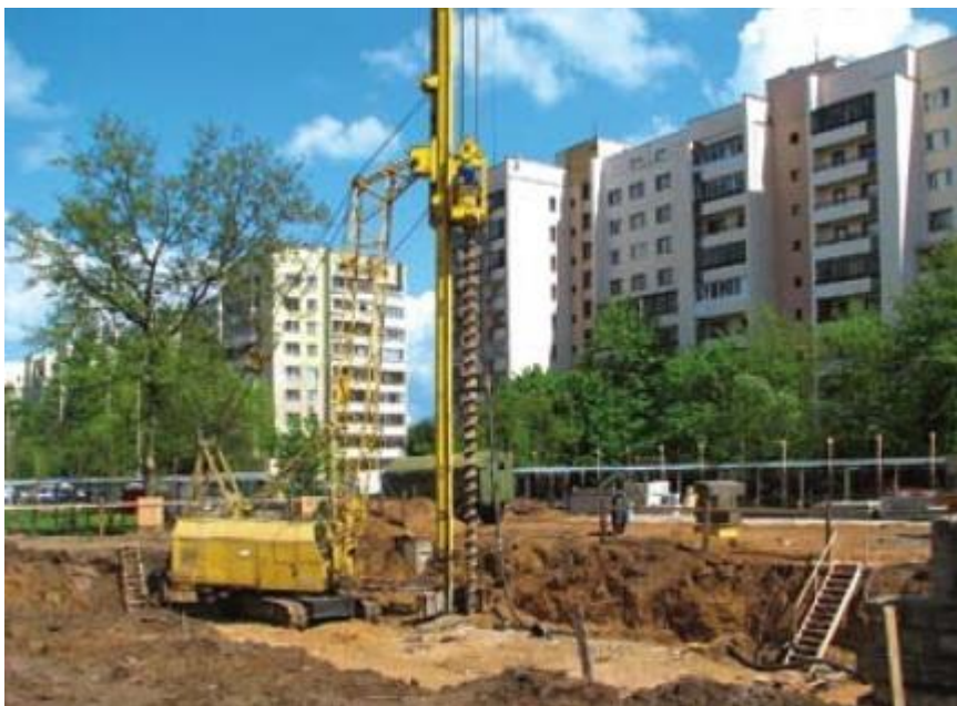
Рис. 3. Общий вид установки для изготовления буропрессионных свай
