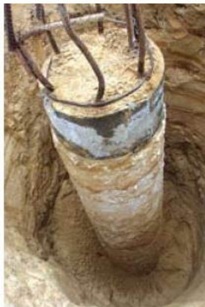
Рис. 4. Общий вид буропрессионной сваи
