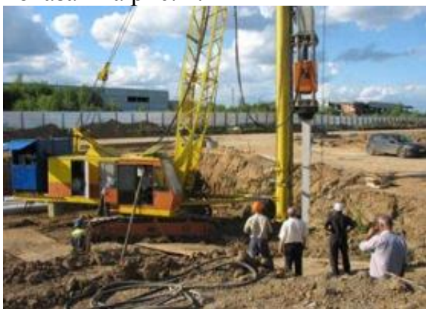
Рис. 1. Погружение свай сваевдавляющая установка СВУ-В-6
