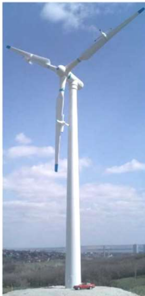
Рисунок 4.18 – Загальний вигляд ВЕУ ТГ-750 виконаної за турбогенераторною схемою
