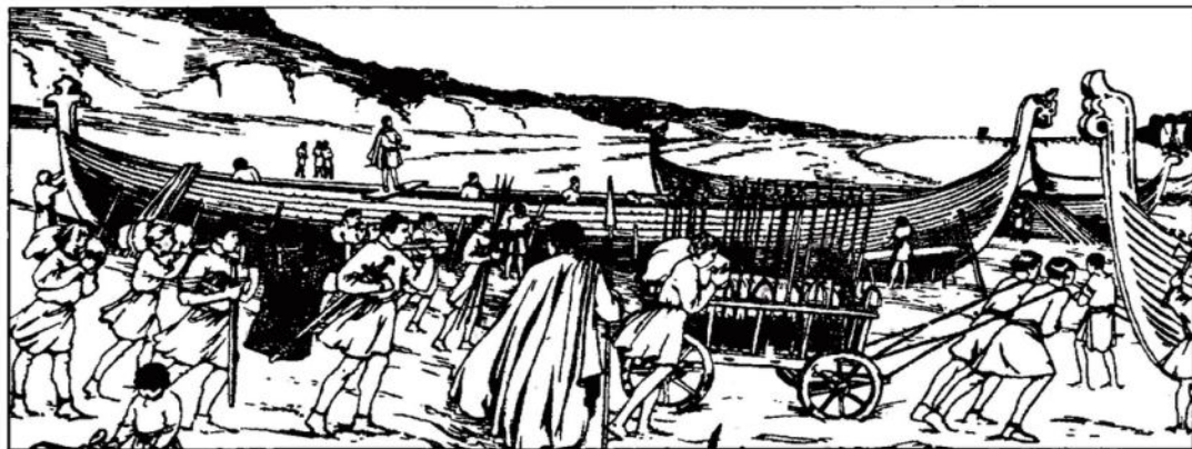
Строительство флота Вильгельма Завоевателя
