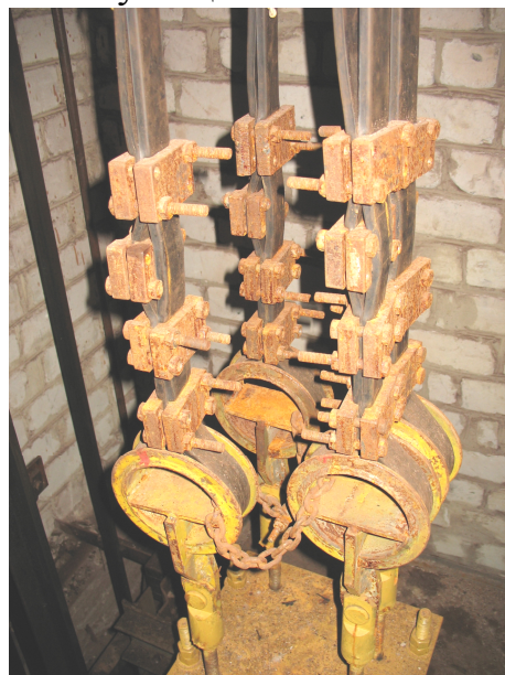
Рис. 24. Приєднання підйомних канатів до kabіни ліфта на пружинних динамометрах
