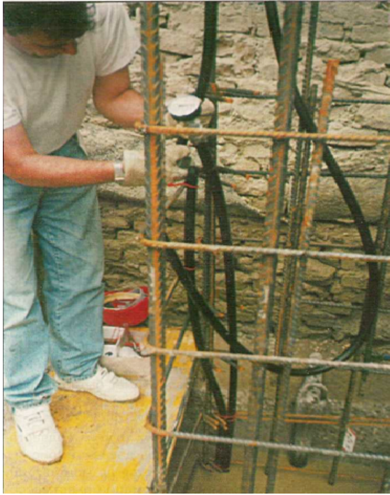
Рис. 2.12. Перевірка герметичності стиків теплообмінника теплового колектора високим тиском безпосередньо перед бетонуванням
