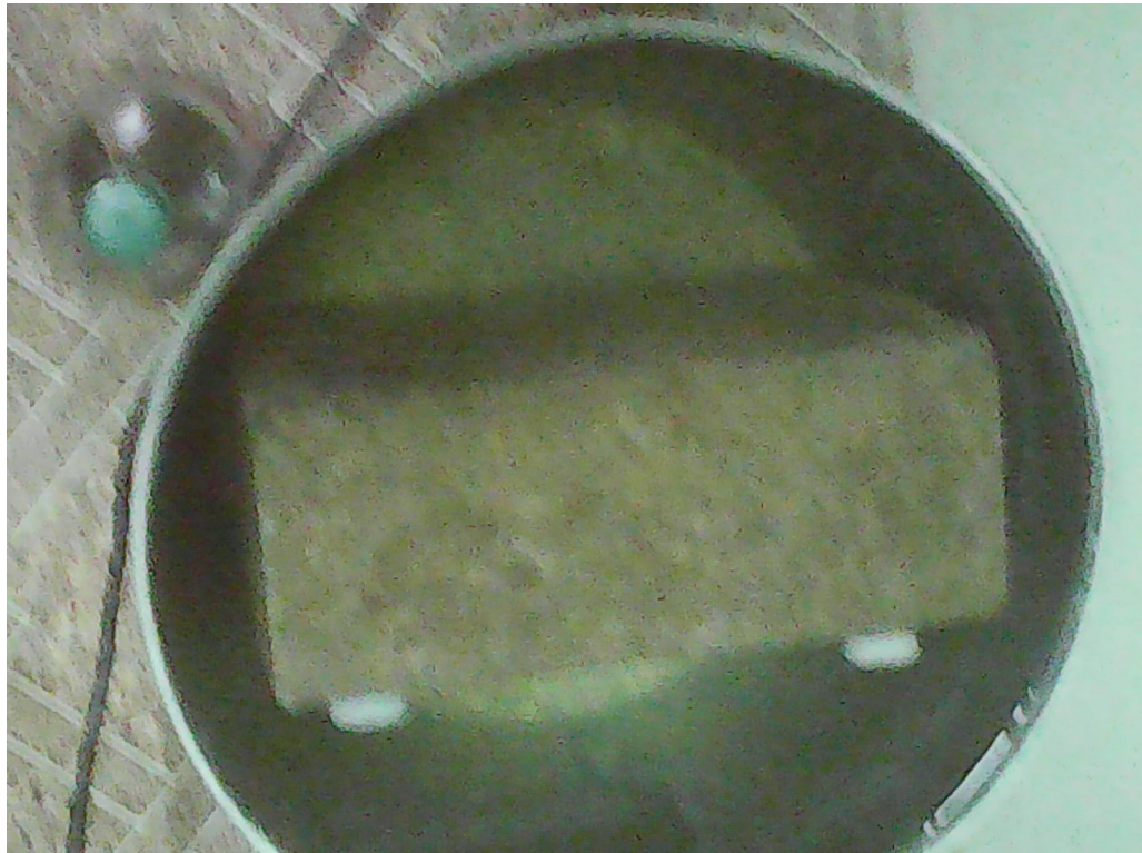
Рис. 4.31. Досліджуваний фрагмент бетонної конструкції
