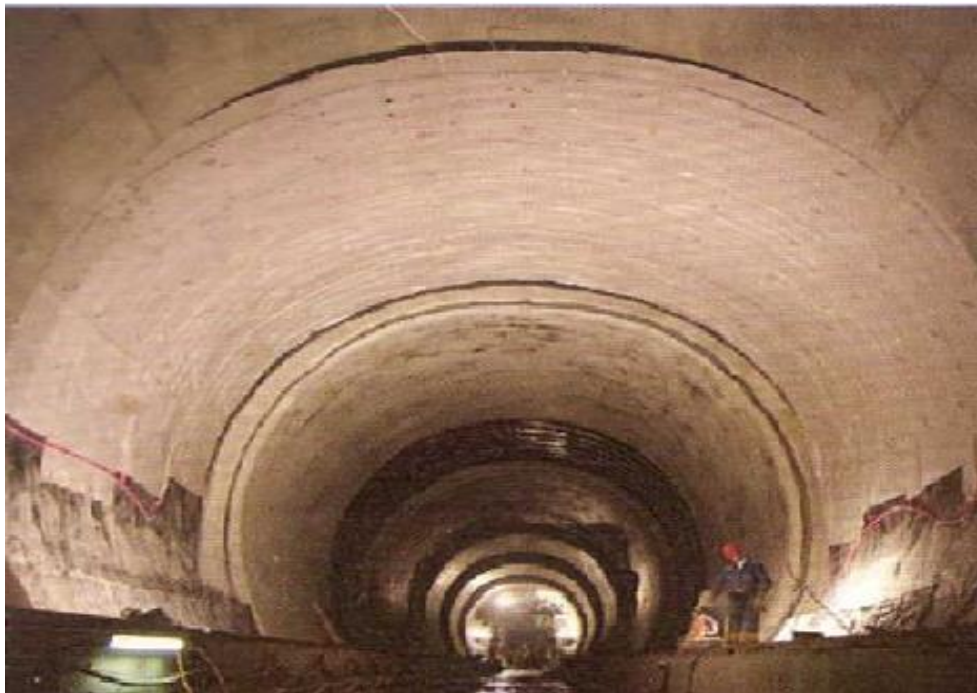
Рис. 2. Монтаж коллектора теплового насоса на опытном участке в туннеле Ляйнцер (Австрия)
