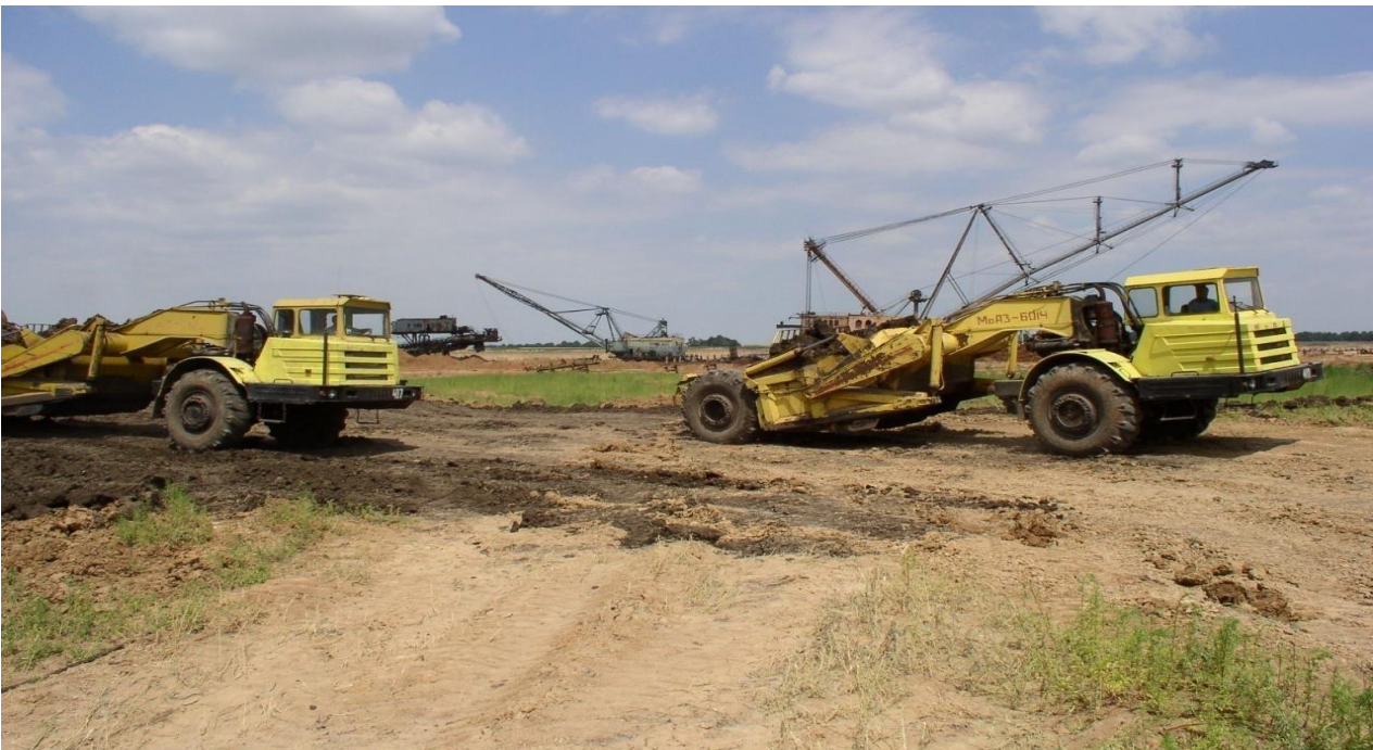
Рисунок 4.5 – Нанесення родючого шару ґрунту скреперами
