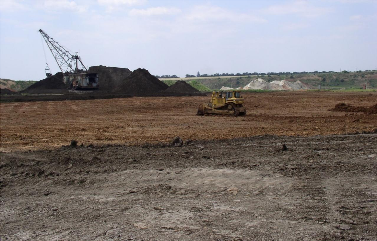
Рисунок 4.4 – Планування поверхні поля бульдозером
