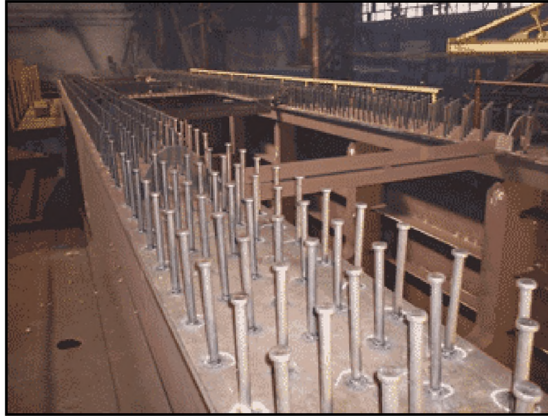
Рисунок 4.2 - Зовнішній вигляд приварених болтів.
