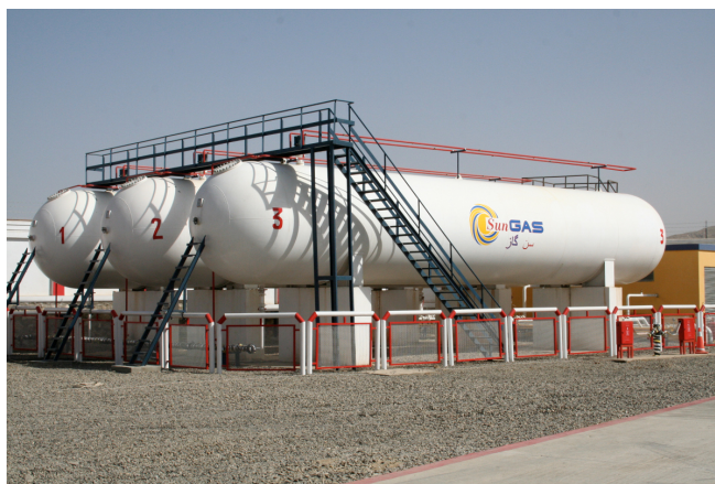
Рис. 4.19. Циліндричні горизонтальні газгольдери
