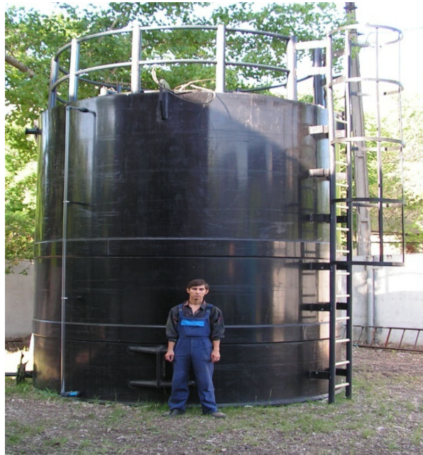
Рис. 2.67. Зварний вертикальний наземний резервуар для нафтопродуктів з поліетилену
