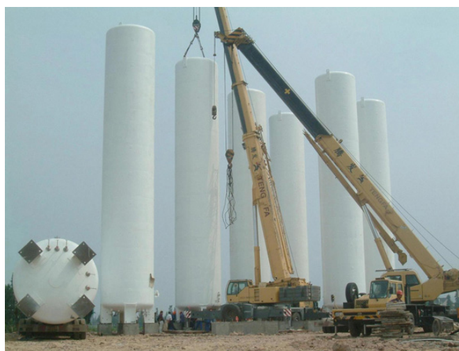
Рис. 4.20. Будівництво вертикальних газгольдерів
