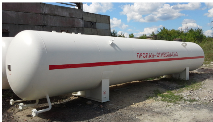
Рис. 4.55. Горизонтальний циліндричний надземний резервуар для пропан-бутану
