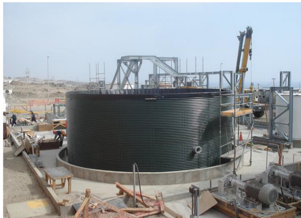
Рис. 2.70. Монтаж гібридного резервуара
