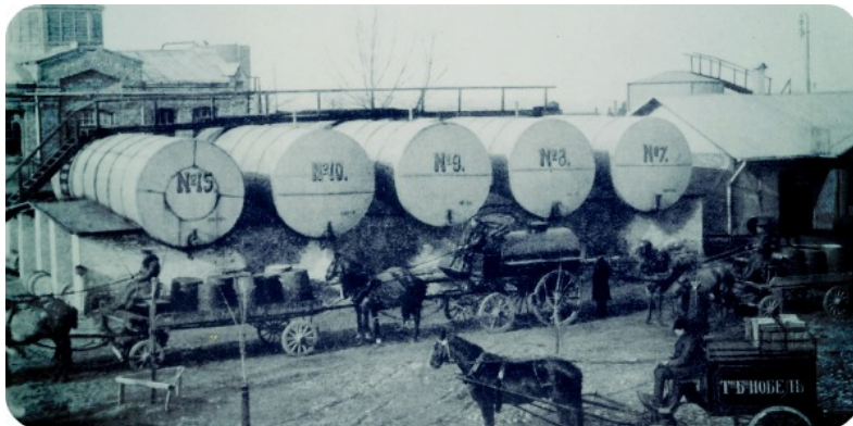
Рис. 1.2. Завантаження гасу в бочки і цистерни для доставки споживачеві гужовим транспортом на нафтобазі
