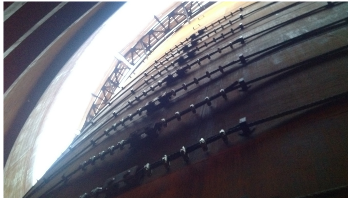
Рис. 2.5. Посилення нижнього пояса резервуара бандажами зі сталевих тросів
