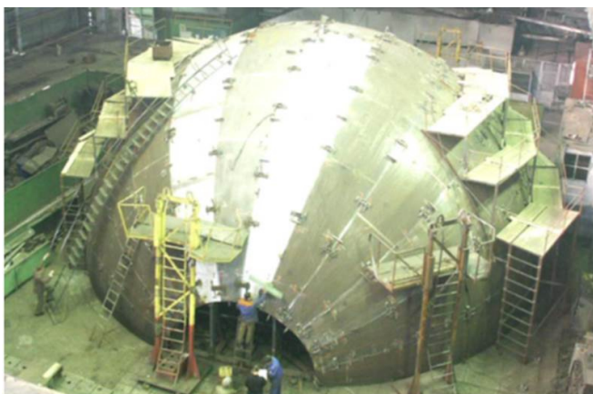
Рис. 4.24. Контрольне збирання кульового резервуара
