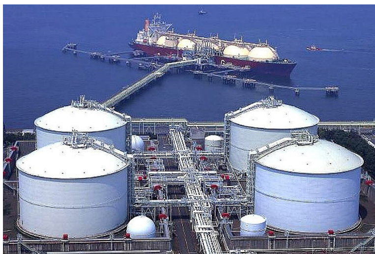
Рис. 4.50. Сталеві циліндричні газгольдери з плоским дном і сферичним дахом у складі портового терміналу з приймання зрідженого газу
