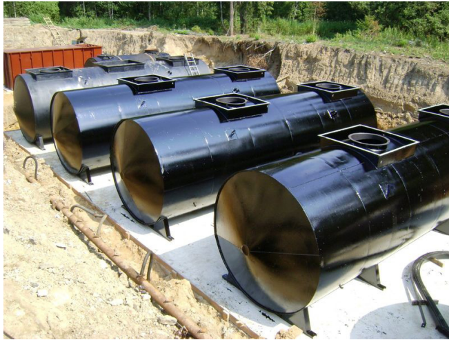
Рис. 2.52. Підземні горизонтальні циліндричні прямокутні резервуари до засипання ґрунту в котлован
