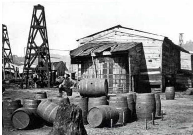
Рис. 1.3. Бочки для перевезення нафтопродуктів на нафтопромислі, на задньому плані – нафтова цистерна з дерева і комора над ямою для нафти
