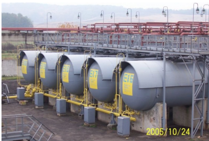
Рис. 4.60. Газгольдери під тіньовими козирками
