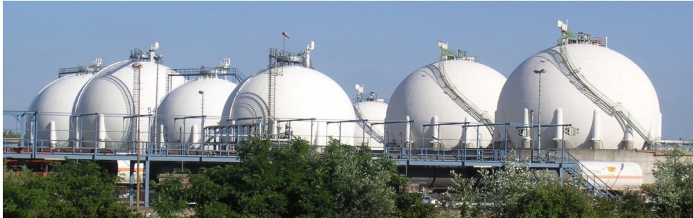
Рис. 2.60. Сферичні монолітні фібробетонні резервуари
