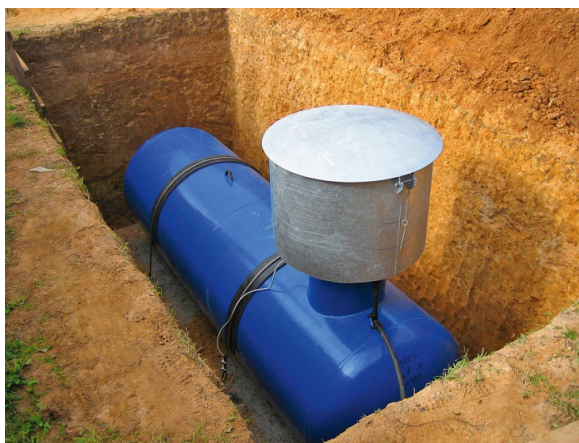
Рис. 4.57. Підземний горизонтальний газгольдер у котловані на фундаментній залізобетонній плиті (до засипання)
