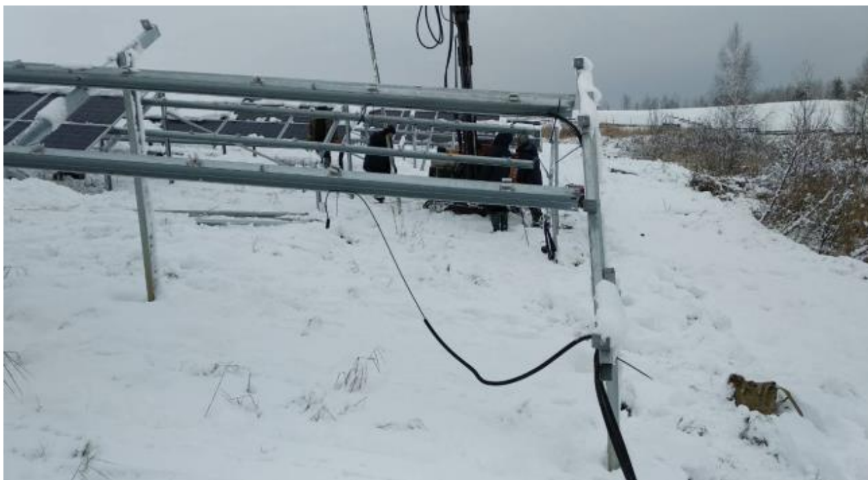
Фотоілюстрація 2 – Вихід з площини П-образної рами стійок-паль по ряду 138 (деформації 125мм).
