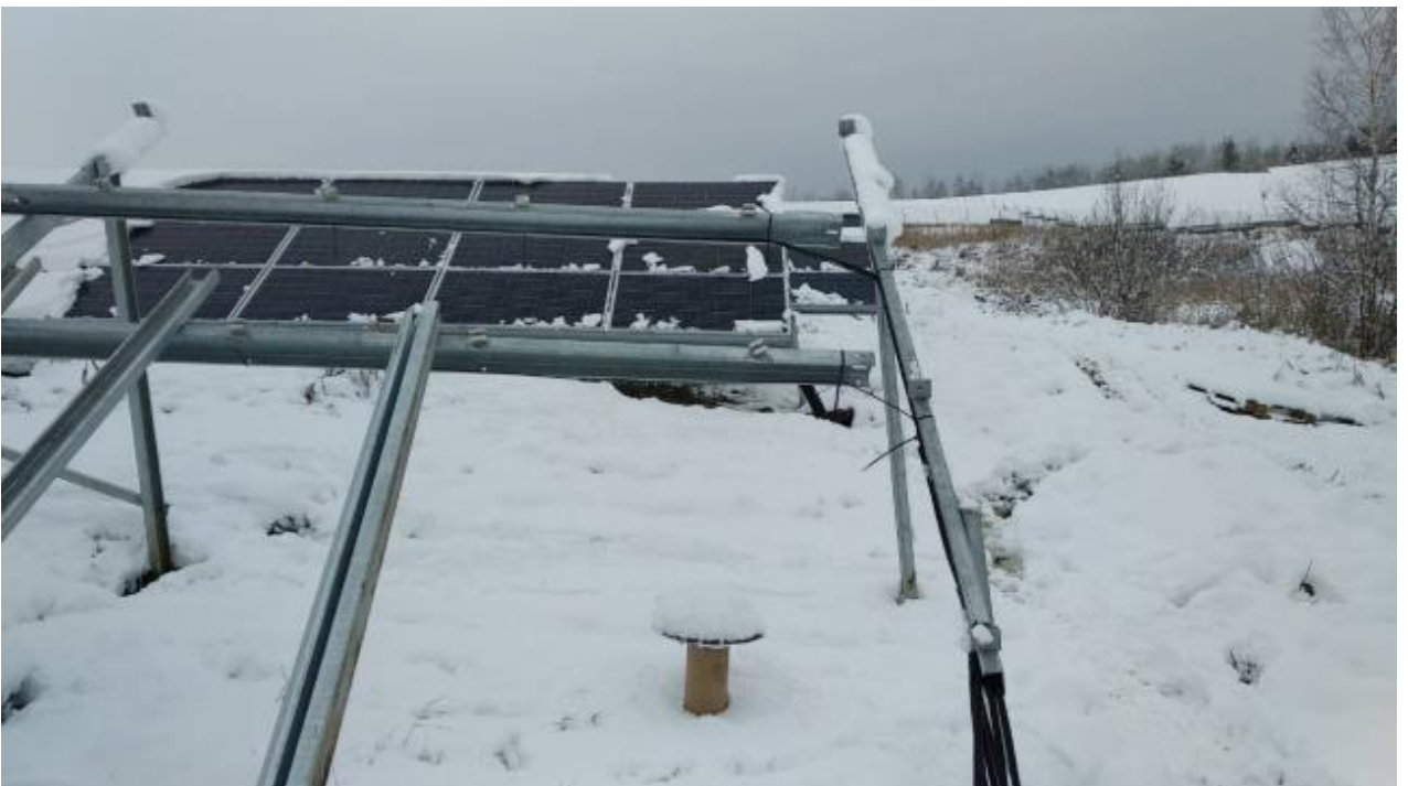
Фотоілюстрація 4 – Вихід з площини П-образної рами стійок-паль по ряду 134 (деформації 185мм).
