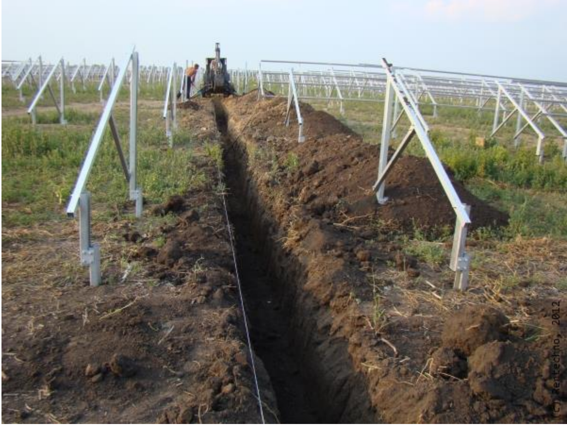
Рисунок 1.16 – Влаштування траншей для підземних кабелів
