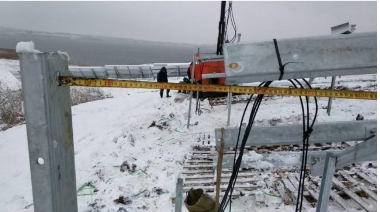
Фотоілюстрація 3 – Вихід з площини П-образної рами стійок-паль по ряду 137 (деформації 350мм).
