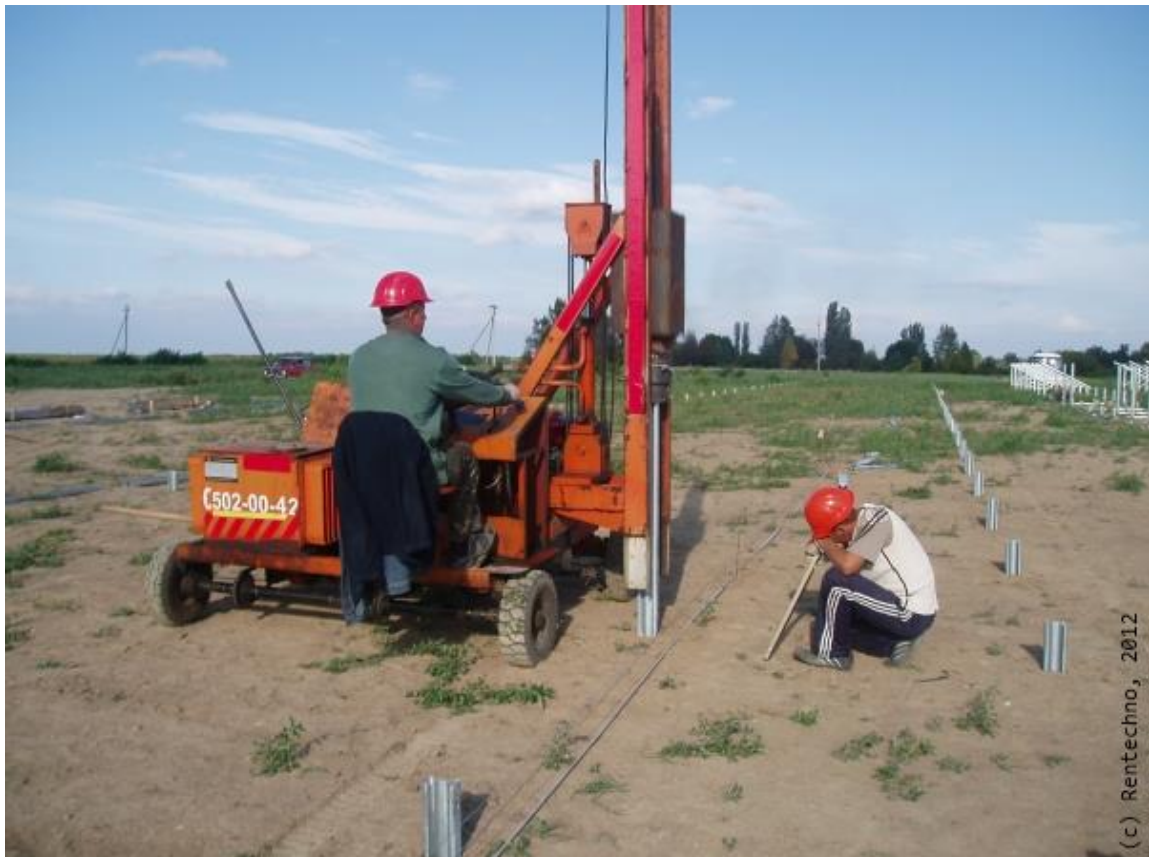
Рисунок 1.12 – Забивання сигма-стійок
