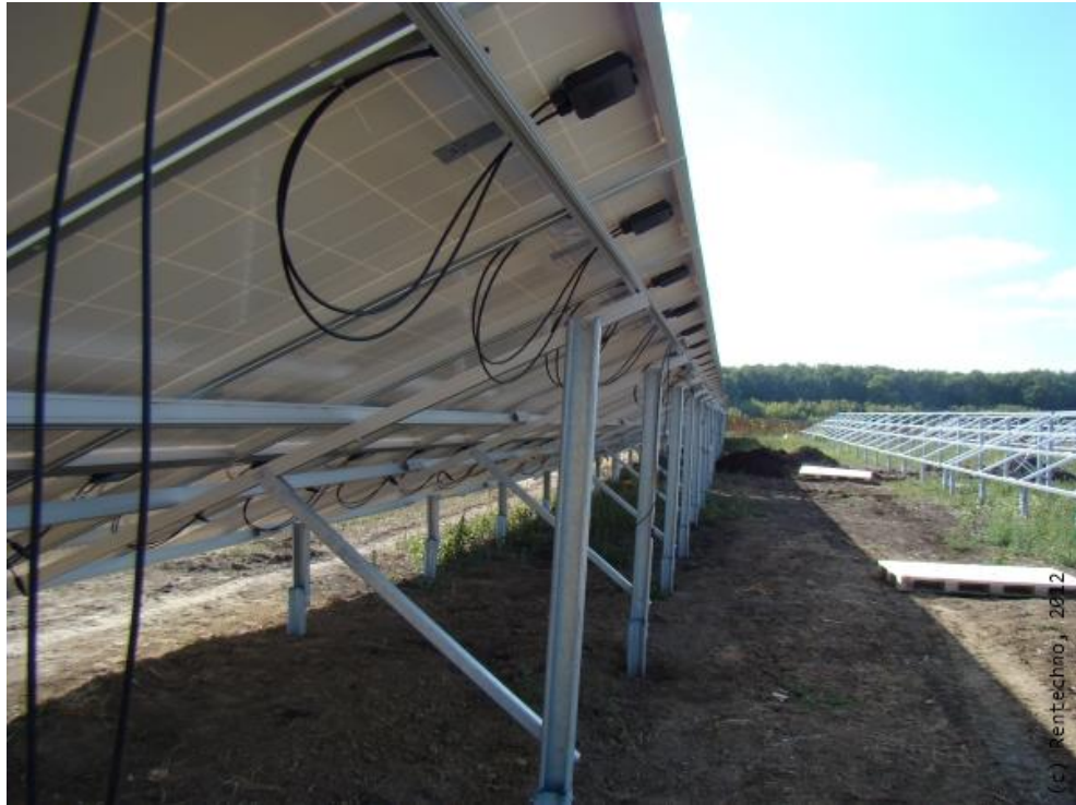
Рисунок 1.19 – Кабелі які не закріпленні
