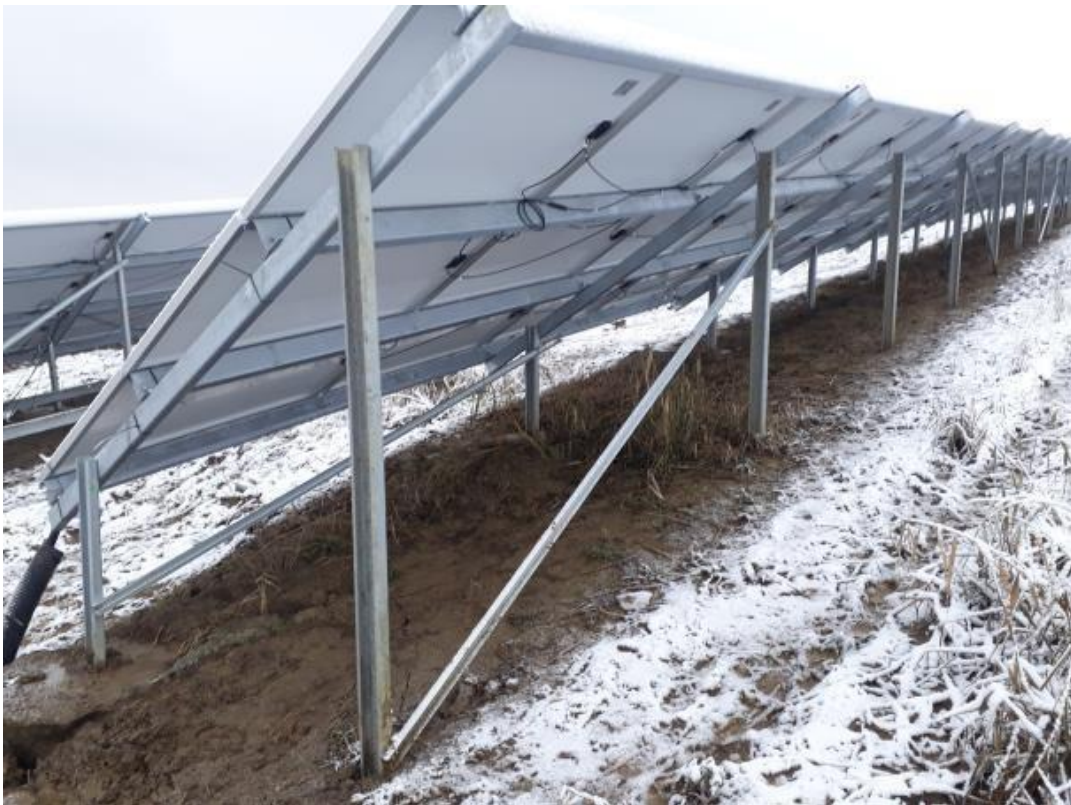
Фотоілюстрація 14 – Конструкції крайнього стола по ряду 133
