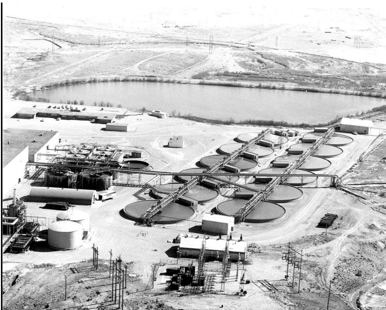
Рисунок 1.6 – Приклад хвостосховища (на передньому плані згущувач пульпи, на задньому саме хвостосховище)
