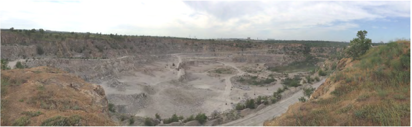
Рис. 3.15. Загальний вигляд нерудного кар'єру після масового вибуху водоемульсійної ВР
