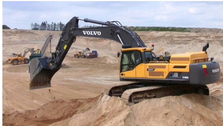
Рисунок 2.8 – Загальний вигляд екскаватора Volvo EC480
