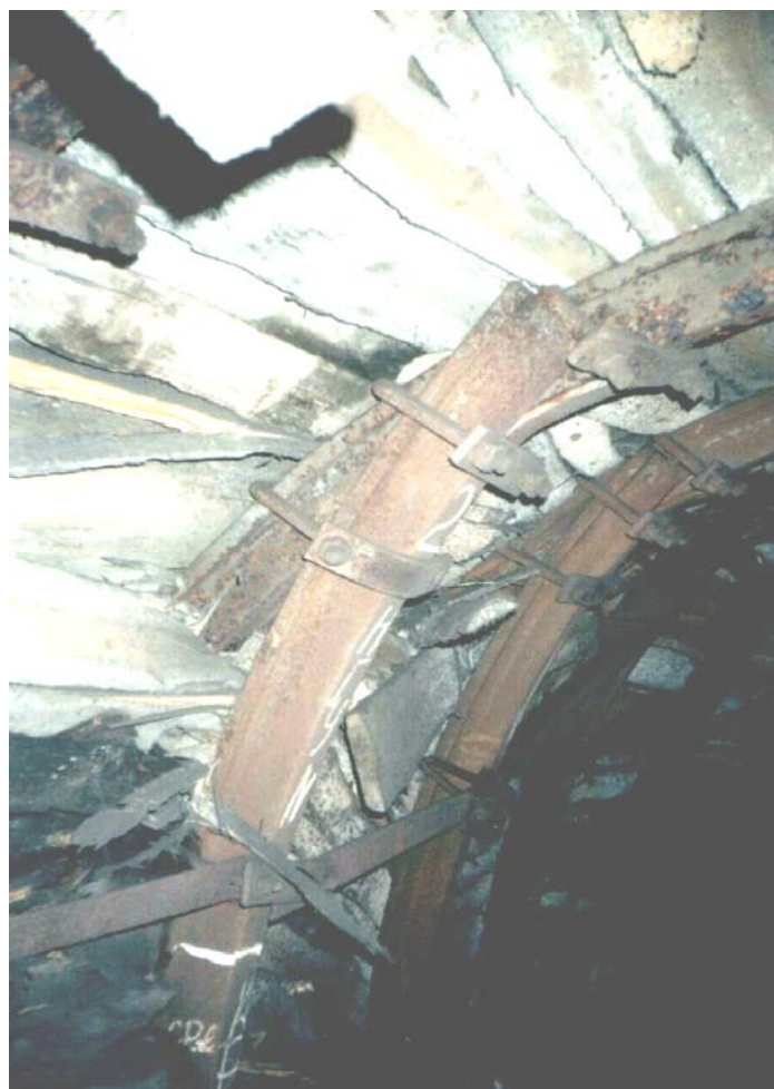
Рис. 3.17 – Деформации крепи 719 бортового штрека а) со стороны выработанного пространства, б) со стороны целика
