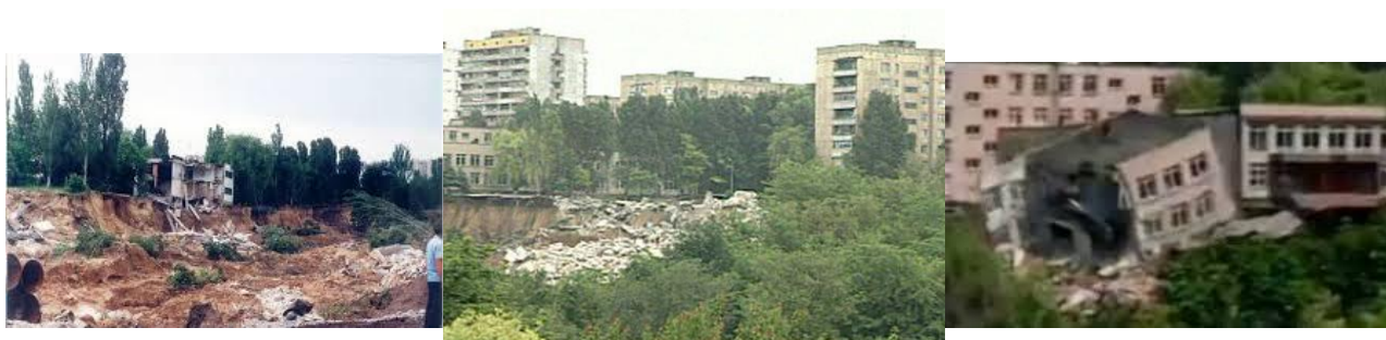
Рисунок 1.2 – Оползень на ж/м “Тополь” (1997 г.)
