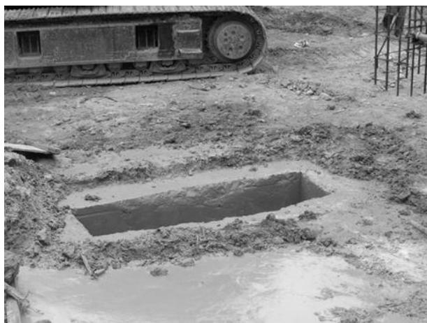
Рис. 1 – Влаштування траншеї грейфером
