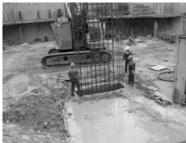
Рис. 2 – Встановлення арматурного каркасу
