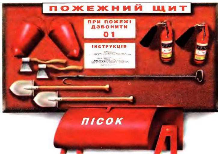
Рис. 25. На пожарных постах находятся огнетушители, ведра, топоры, лопаты, крюки, лестницы, ведра с водой, которые зимой заменяют ящиками с песком
