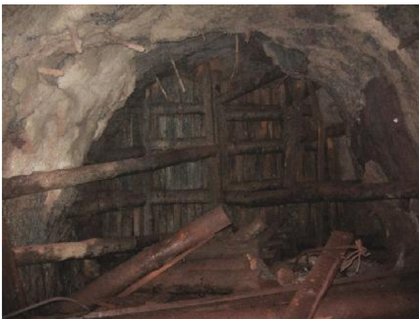
Рис. 4.6. Вид деревянной изолирующей перемычки в подземных условиях
