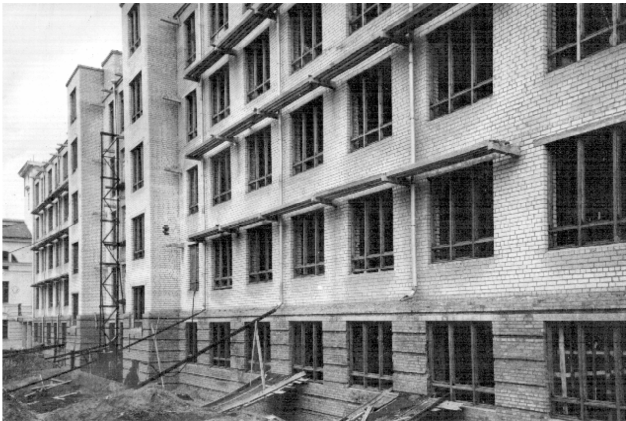
Будівництво навчального корпусу ДГІ на просп. К. Маркса (осінь 1967 року)
