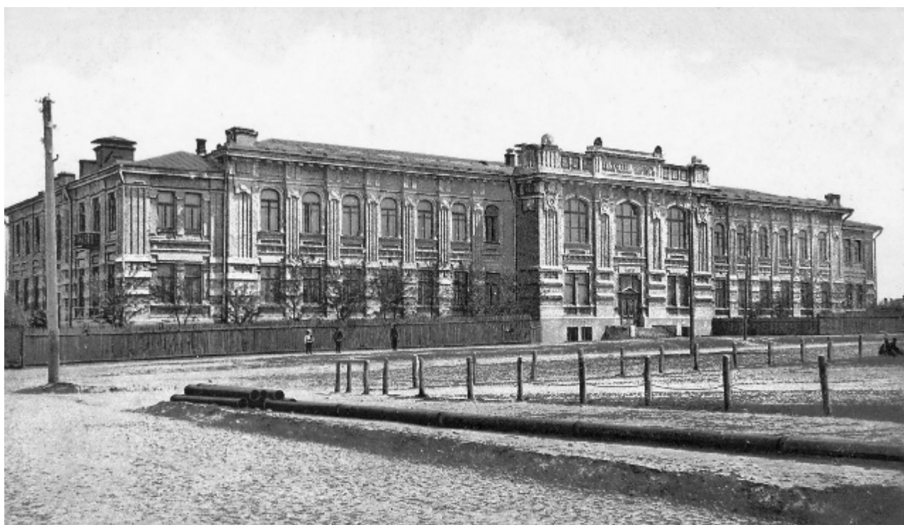
Навчальний корпус № 2 (хімічний) на початку ХХ ст.
