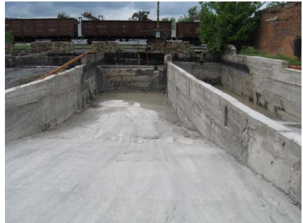
Рис. 5.9. Отстойники для осветления вод оборотного водоснабжения: а) – вертикальный отстойник; б) – горизонтальный отстойник
