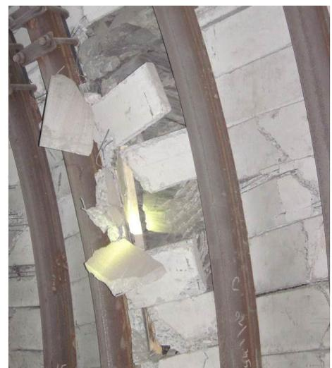
Рис. 4. Поломка железобетонной затяжки
