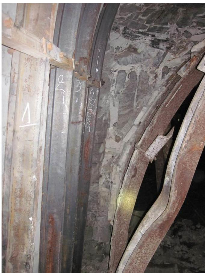
Рис. 2. Выдавливание пород в боках выработки
