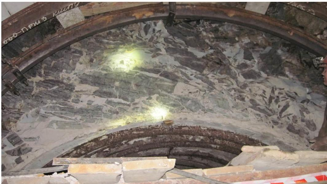
Рис. 1. Выдавливание пород кровли выработки
